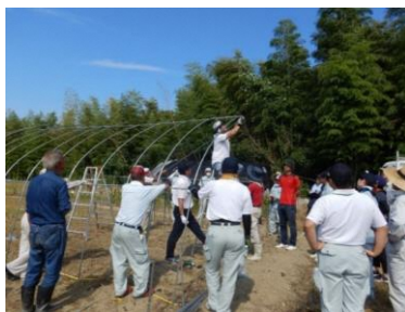
自力施工講習会
