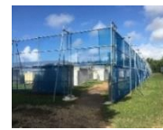
防風ネットの設置
