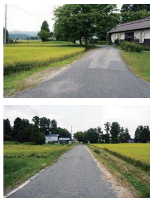
町道 南館深淵線 工事起点
