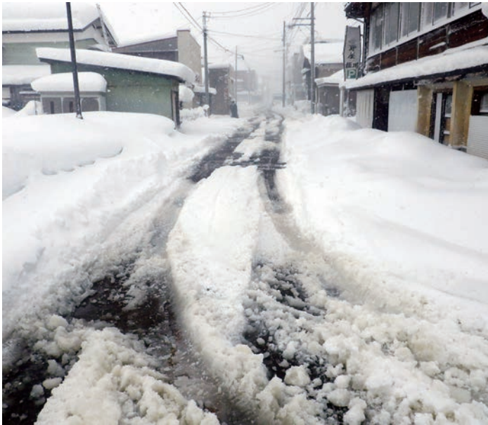
改修がすすまない消雪道路（写真は萩生地区）
