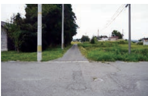
町道 樺南館線 工事起点
