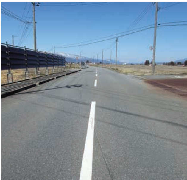
雪のない走行しやすい道路
