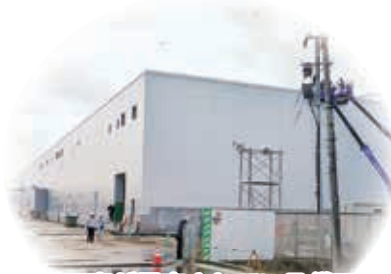
外構工事が予定されている貸工場
