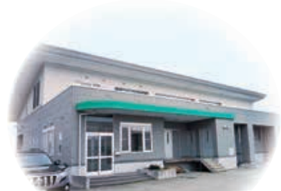
改修工事予定の共同調理場
