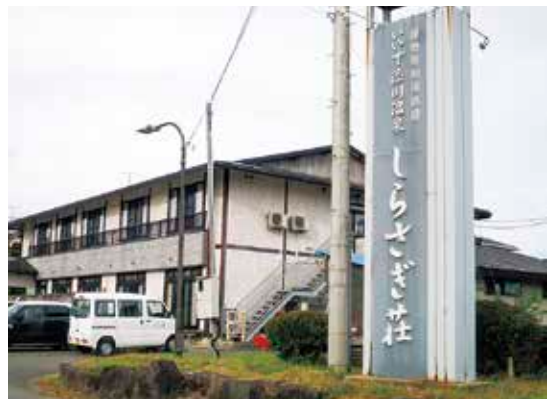
木質チップボイラー導入先のしらすぎ荘
