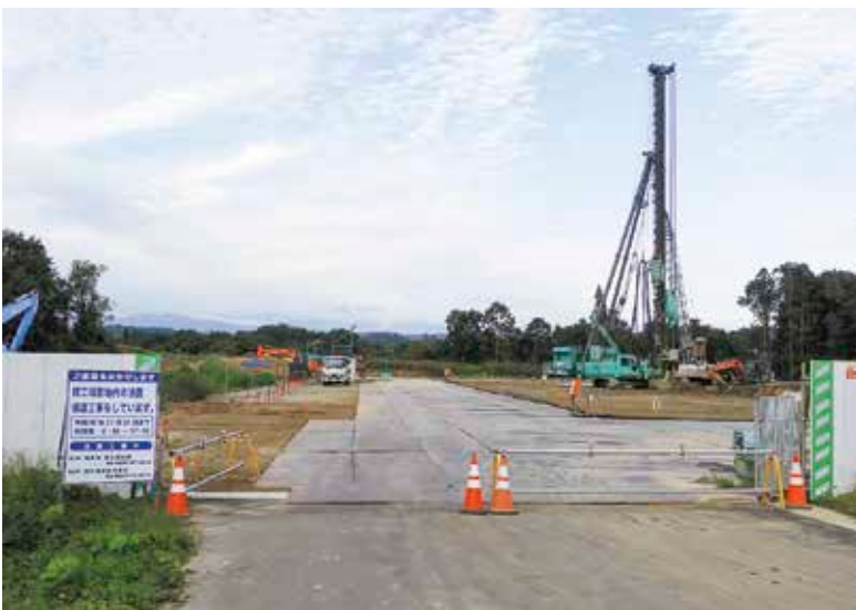
工事中の貸工場 経済活性化への期待
