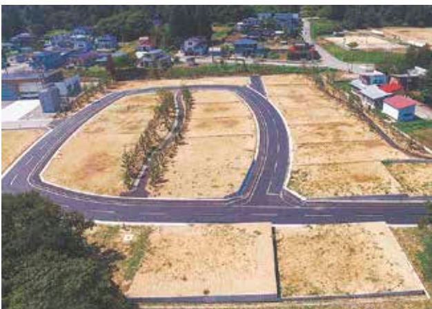
造成完了した椿住宅団地
