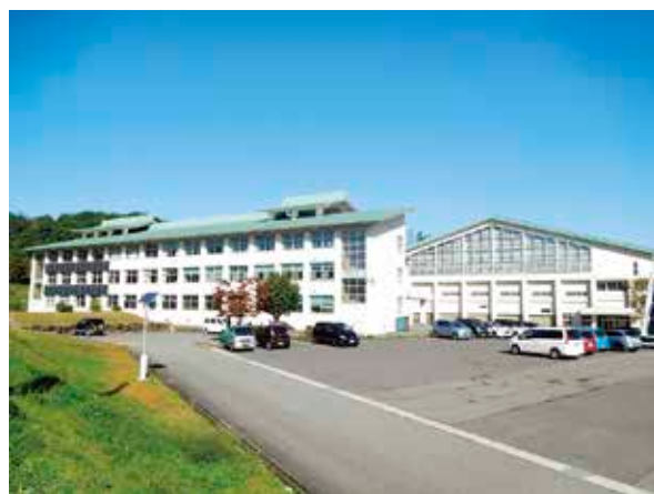
大規模改修工事が本格化する中学校
