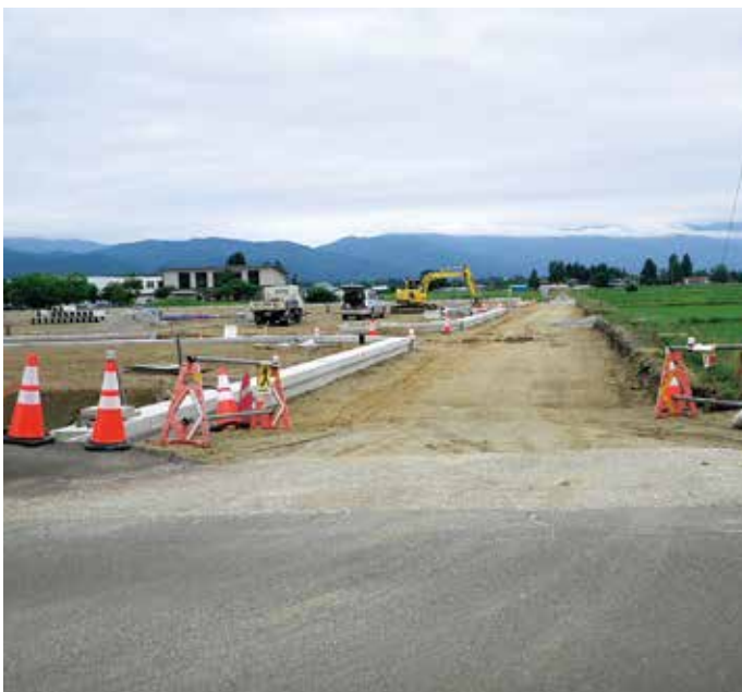
添川住宅団地造成
