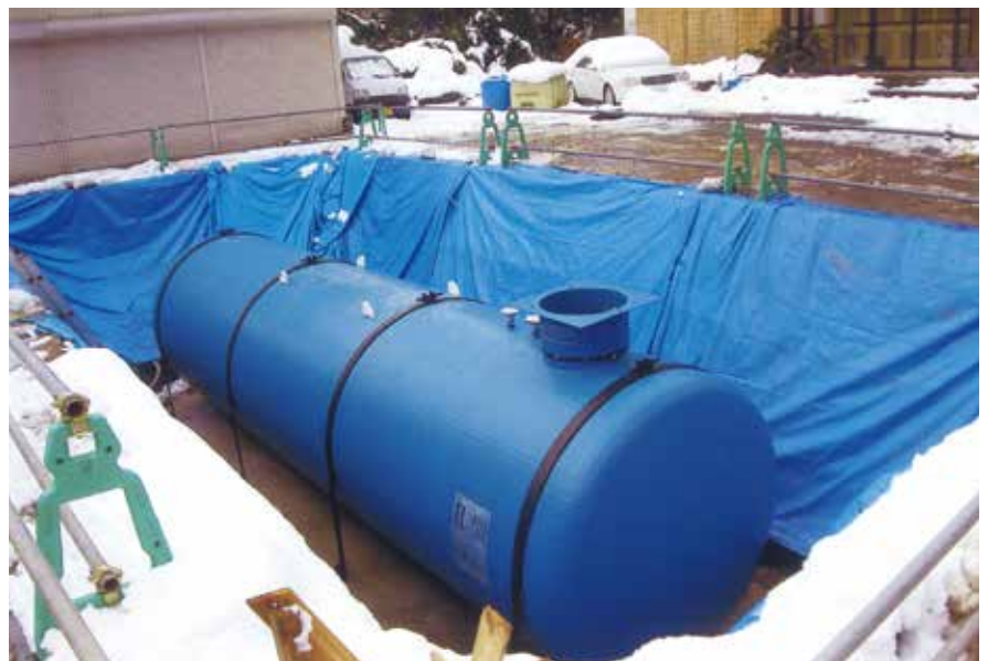
耐震貯水槽設置
