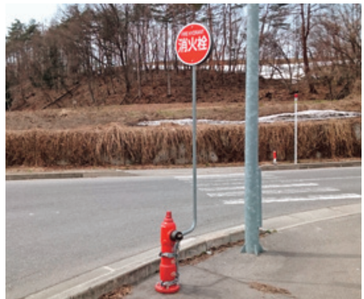
町道手ノ子向原線に消火栓設置
