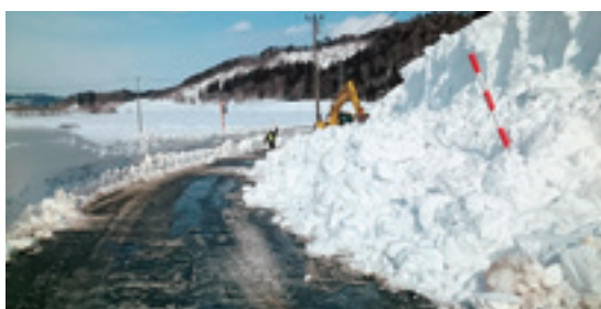
苦労した除雪作業
