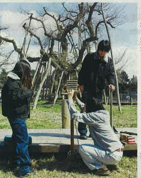
伊佐沢の久保校周辺で照明灯の設置作業を行う学生たち
