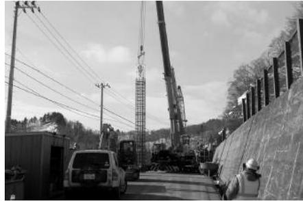
杭打ち工事（鉄筋かご吊込み状況）
