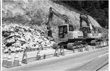
準備工事（既設コンクリート擁壁取壊し状況）
