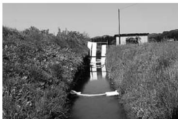
(写真：オイルフェンスやオイルマットで、流出した油の拡散を防ぐ様子)
