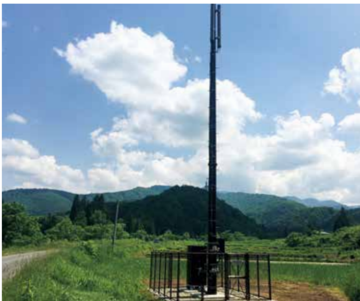
小屋地内の通信用鉄塔
