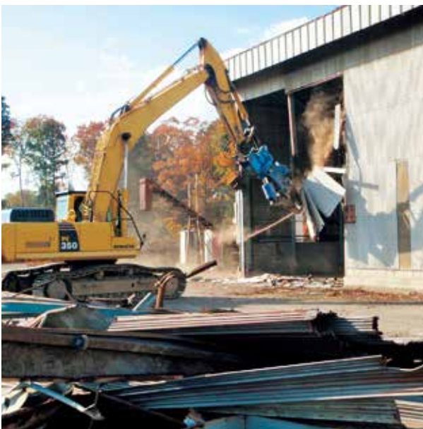
貸工場用地造成のため建物解体
